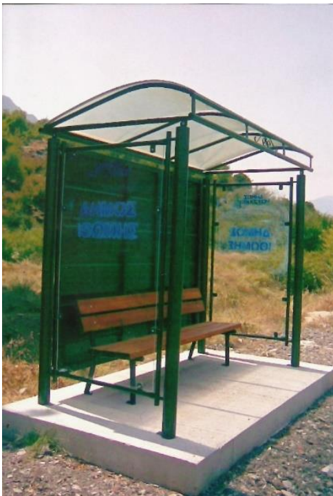
Εικόνα 5-2 Υφιστάμενο σκέπαστρο στάσης με πλήρη απουσία πρόσβασης λόγω υψομετρικής διαφοράς
