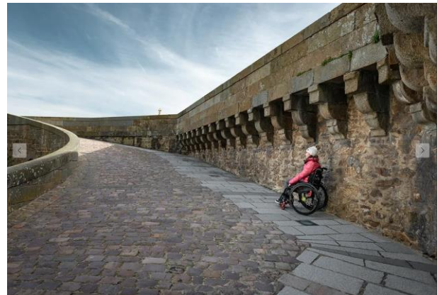
Εικόνα 3-2 Διαμόρφωση διαδρόμου κύλισης κατάλληλου για αμαξίδιο μέσα στο χώρο του Κάστρου του Εδιμβούργου
