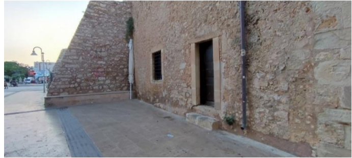
Εικόνα 5-39 Η λωρίδα όδευσης τυφλών μπροστά από το Νερατζέ τζαμί η οποία δεν οδηγεί σε είσοδο ούτε σε διαμορφωμένους χώρους της πλατείας
