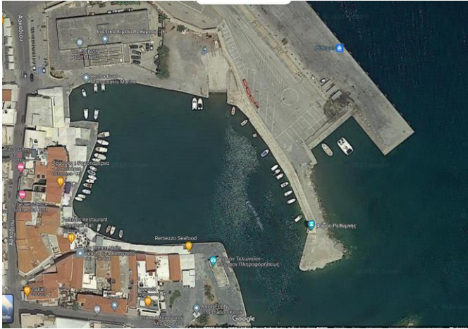
Εικόνα 5-20 Αεροφωτογραφία του ενετικού λιμένα
