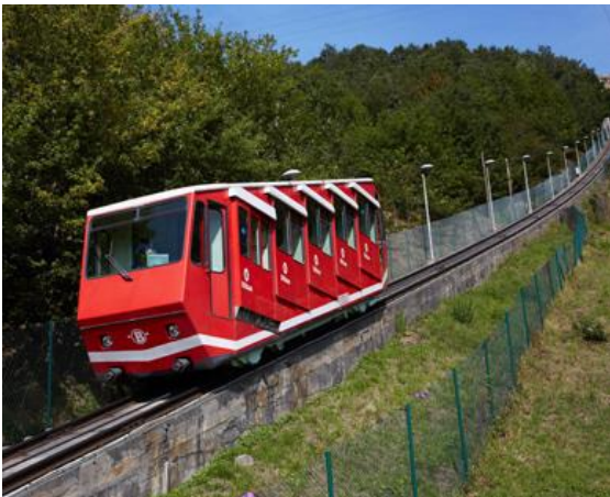
Εικόνα 5-28 Εικόνα τελεφερίκ για την κάλυψη υψομετρικών διαφορών
