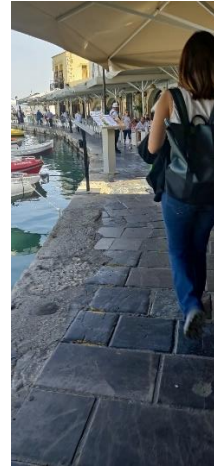
Εικόνα 5-21 Χαρακτηριστική εικόνα της προβληματικής διέλευσης πεζών στον ενετικό λιμένα με ανομοιογενή υλικά δαπεδόστρωσης και στενότητα λόγω κατάληψης χώρου από καταστήματα αναψυχής
